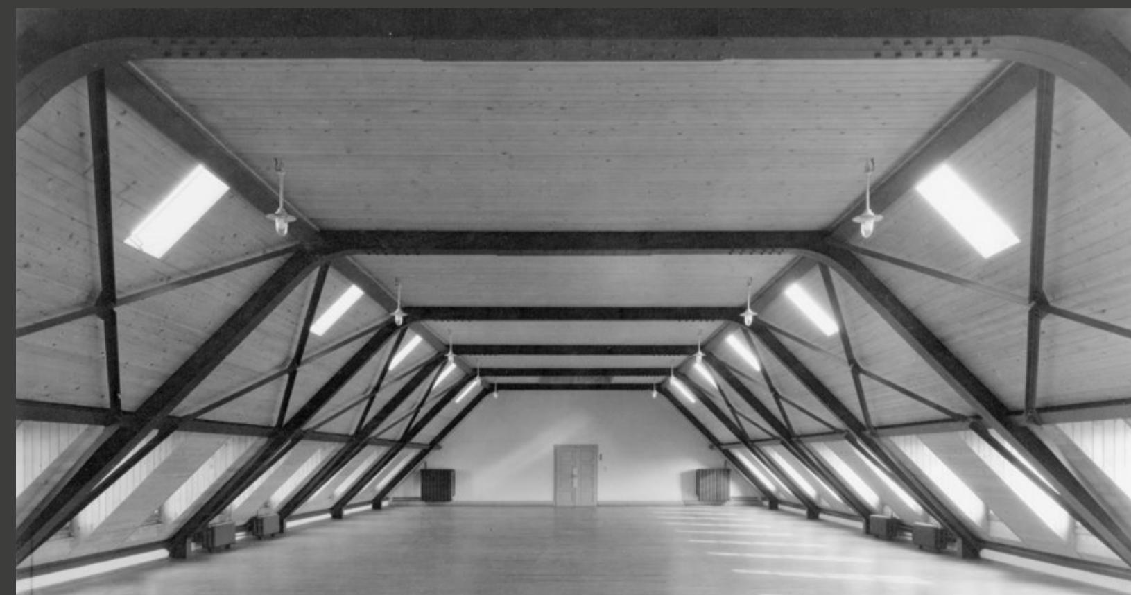
Die Turnhalle im Dachgeschoss des Genossenschaftshauses; Photo: Hoffmann, Basel, 1924
