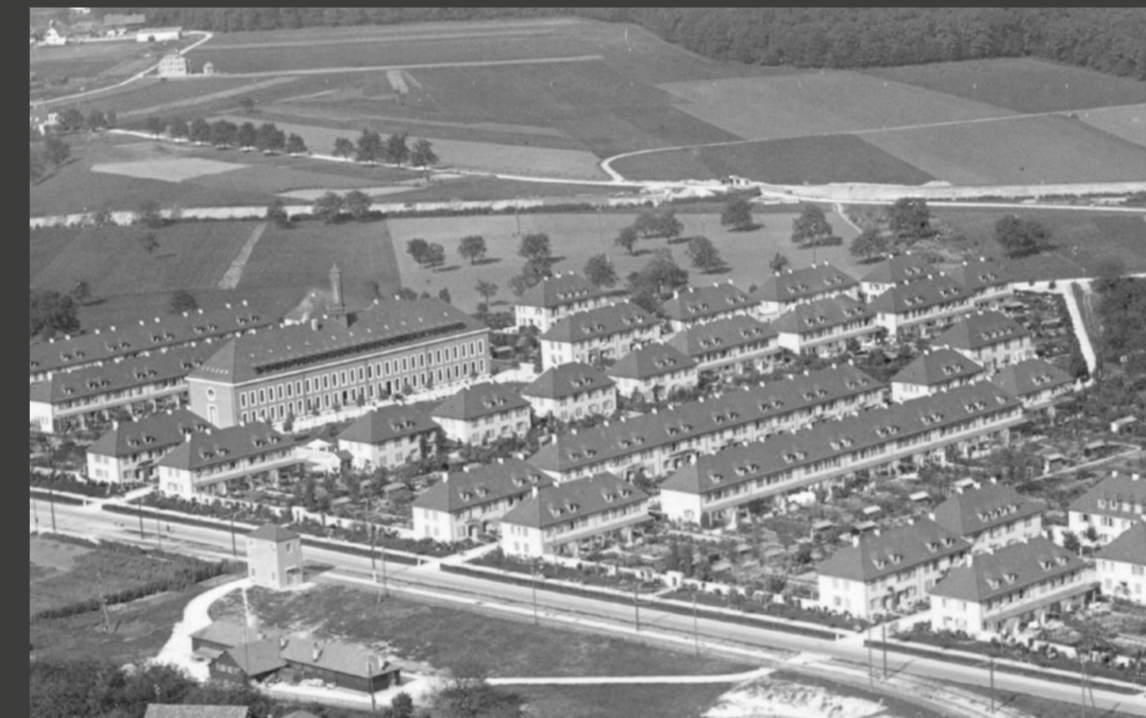
Freidorf, im Vordergrund die Kantine und das Transformatorenhaus, wohl ca. 1930
