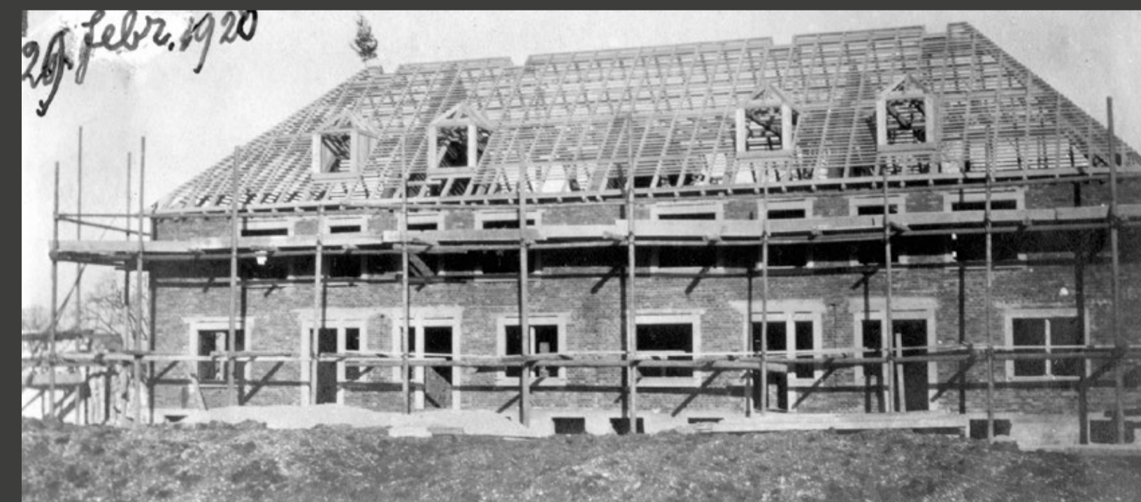
Zwei Häuser des Typs I und zwei des Typs IA im Rohbau
