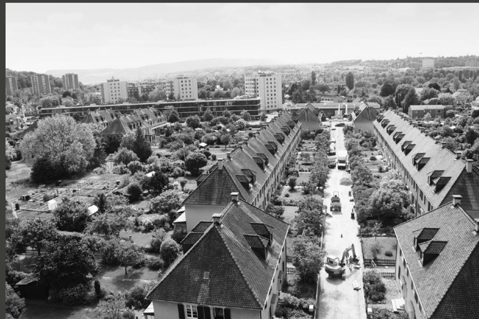
Renovation der Strassen; Photo: Peter Indermühle, Freidorf, 2014
