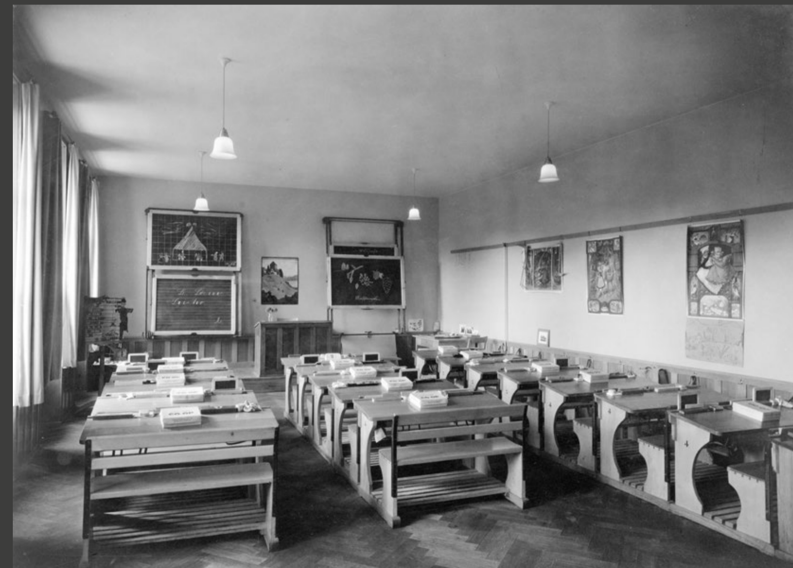
Klassenzimmer im Genossenschaftshaus; Photo: Hoffmann, Basel, 1924
