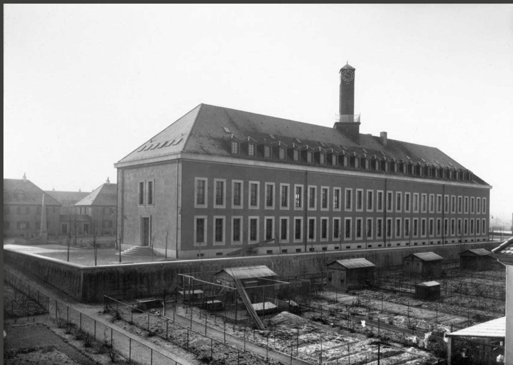
Das Genossenschaftshaus von der Gartenseite aus; Photo: Hoffmann, Basel, 1924
