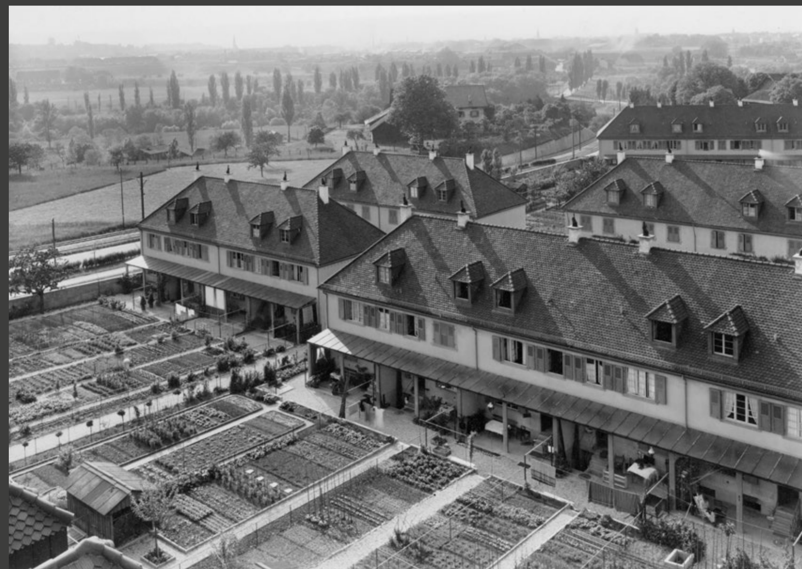
Aussicht vom Genossenschaftshaus nach Westen; Photo: Hoffmann, Basel, 1924
