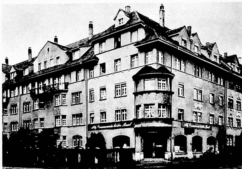
Eichenstrasse 3, 5, 7 und Buchenstrasse 24
