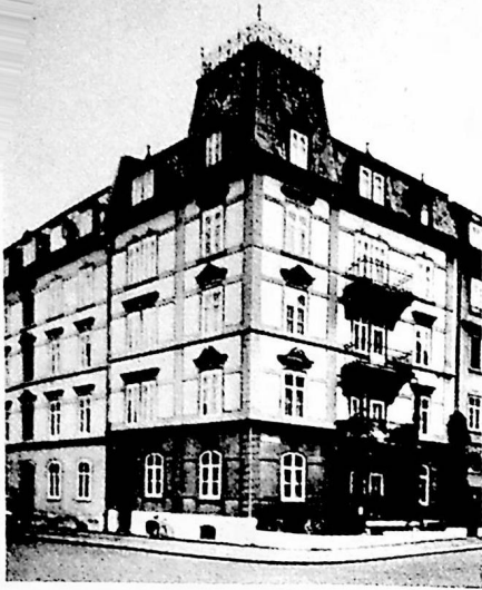
Eckhaus an der Metzgerstrasse
