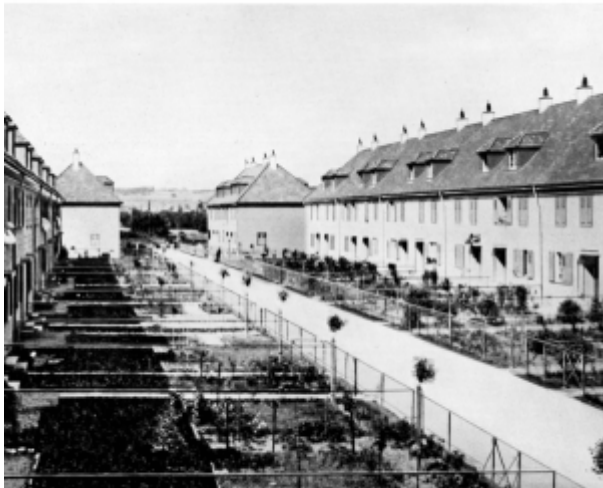
Blick in den Wohnhof
